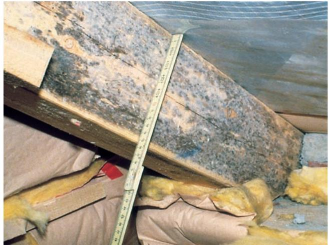
Dieser Sparren ist von ausströmender warmer und feuchter Raumluft so stark durchnässt worden, dass er begonnen hat zu faulen.
