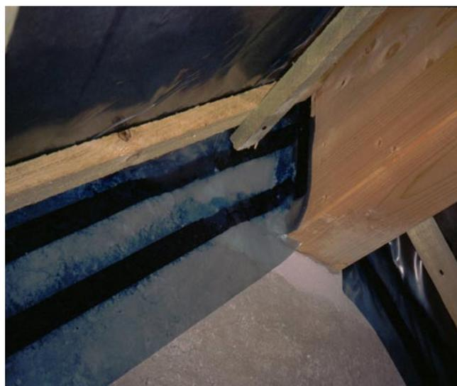
Hier wurde die Dampfbremsfolie zweifach mit doppelseitigem Butylkautschukklebeband an der Giebelwand befestigt. Anschließend werden die Verklebungen mit Andruckleisten fixiert.
