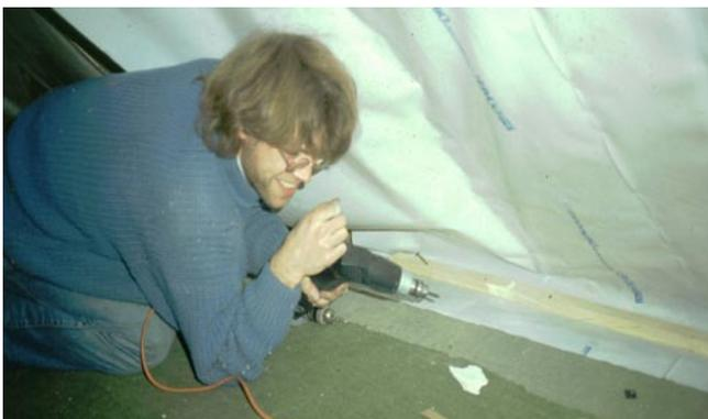
Hier wird beim Dachausbau im Altbau die Dampfbremse mit doppelseitigem Klebeband und einer Anpressleiste am Betonboden verschraubt.
