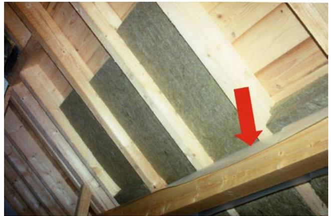
Gut geplante Arbeit ist leicht und effektiv! Wird vor dem Auflegen der Sparren auf die Pfetten ein stabiler Folienstreifen gelegt, ist der dichte Anschluss der Dampfbremse kein Problem mehr.
