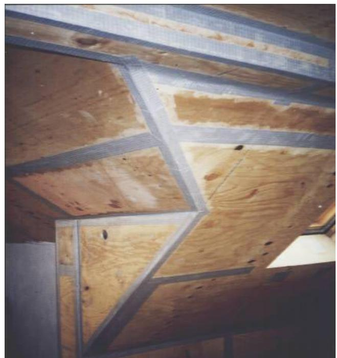
Auch ohne die Verwendung von Folien ist die Herstellung einer luftdichten Ebene möglich. Bei diesem Gebäude wurde sie mit Sperrholztäfelung realisiert. Die Abdichtung der Fugen erfolgte mit gewebeverstärktem Klebeband.
