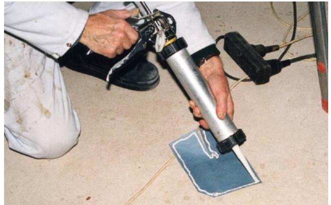
Dieser Flicker wird die leicht eingerissene Ecke an der Laibung des Dachfensters (s. Bild links) abdichten.
