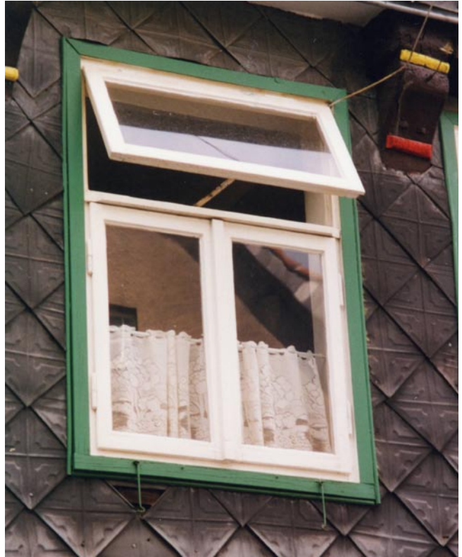
Vermeidbare Energieverluste entstehen Jahr für Jahr durch diese einscheibenverglaste Fenster.
