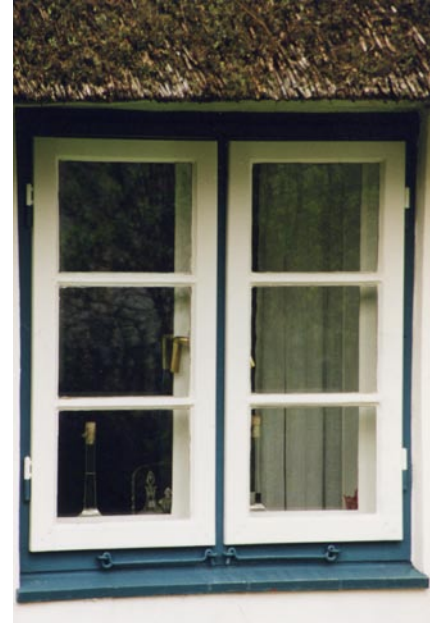
Kastenfenster in einem Haus in Norddeutschland
