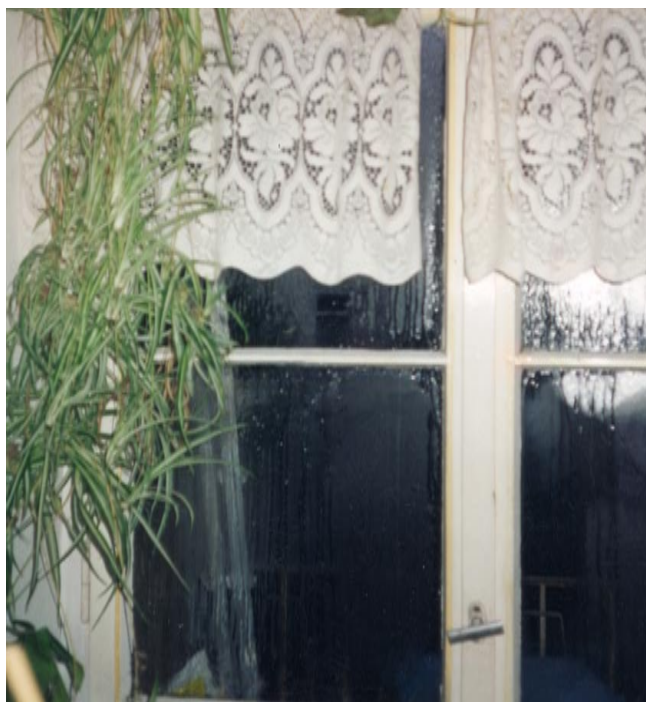
Ablaufendes Kondenswasser an einem einfach verglasten Fenster
