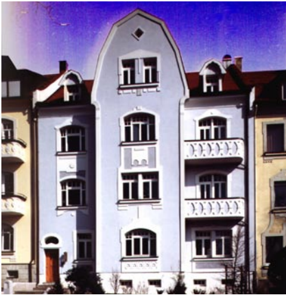
Auch dieses historische Gebäude wurde mit einem Wärmedämmverbundsystem saniert. Von den Ornamenten auf der Fassade wurden Abgüsse gemacht und anschließend aus Dämmmaterial nachgebildet.
