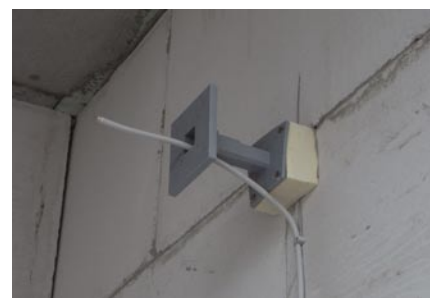
Spezialhalter für die wärmebrückenarme Befestigung von Schaltern und Außenleuchten
