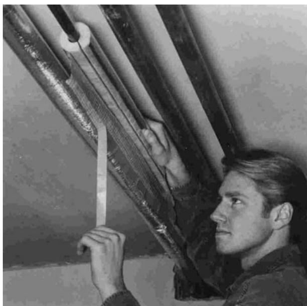
Ungedämmte Rohrteile im Heizungskeller lässt die Energieeinsparverordnung nicht zu
