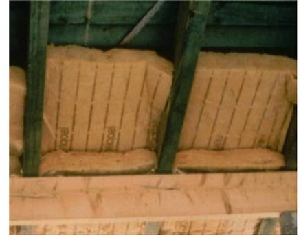
20 cm Sparrenhöhe sichern bei diesem Neubau eine Dämmstärke von 20 cm zwischen den Sparren (unbelüftet). Unter den Sparren werden zwischen der Traglattung der Innenkleidung 24 mm starke Dämmplatten ausgeführt. Eine Weichfaserplatte als Unterdach bietet einen zusätzlichen kleinen Wärmeschutz auf dem Sparren. Der U-Wert beträgt  $0,19 \text{ W}/(\text{m}^2 \cdot \text{K})$
