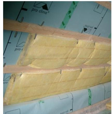
Untersparrendämmung 50 mm zwischen der Unterkonstruktion
