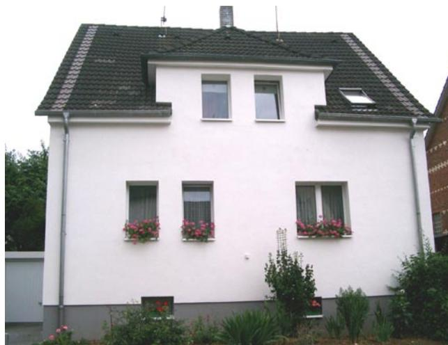
Bei diesem Haus wurde der Dachüberstand um eine Ziegelbreite vergrößert, um eine Außenwanddämmung möglich zu machen. Die Reihe der neuen Ziegel dient dabei auch als Gestaltungselement.
