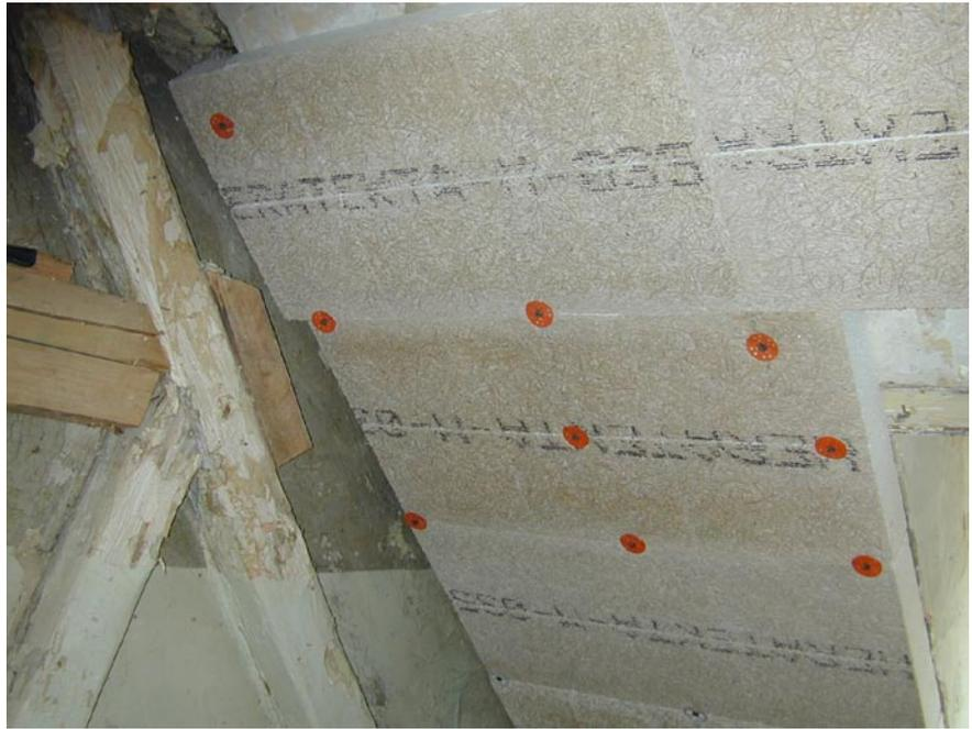
Die Hartschaumverbundplatten wurden unter den alten Innenputz der Dachschräge befestigt. Sie werden verputzt. Der Innenputz ist die notwendige luftdicht-
