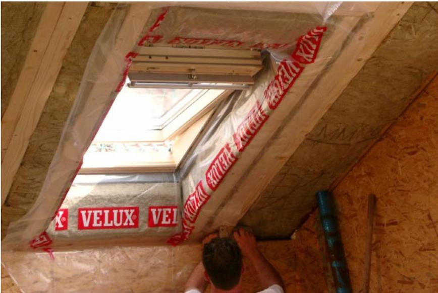
Die in der Produktverpackung mitgelieferte Folien-Manschette eines Dachflächenfensters wird in die Leibung eingebaut und muss später fachgerecht an die Dampfsperre und/oder Luftdichtheitsschicht angeschlossen werden.
