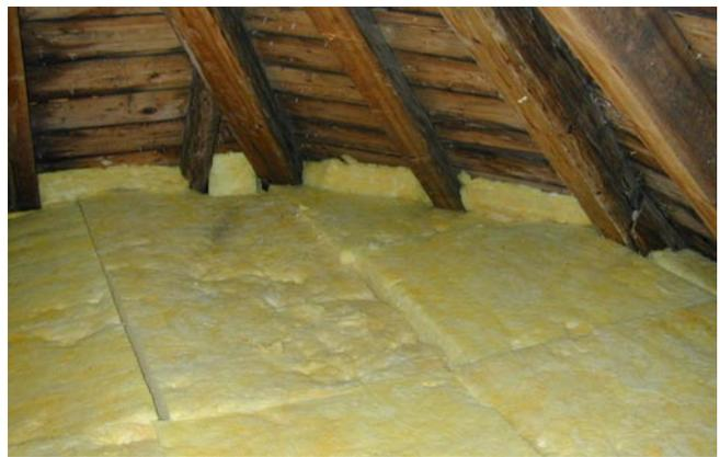
Mineralfaserplatten von 20 cm Stärke dämmen diesen Spitzboden. Die Platten sind auch in den Sparrenzwischenraum hineingeschoben. Damit schließt die Dämmung an die Zwischensparrendämmung lückenlos an.
