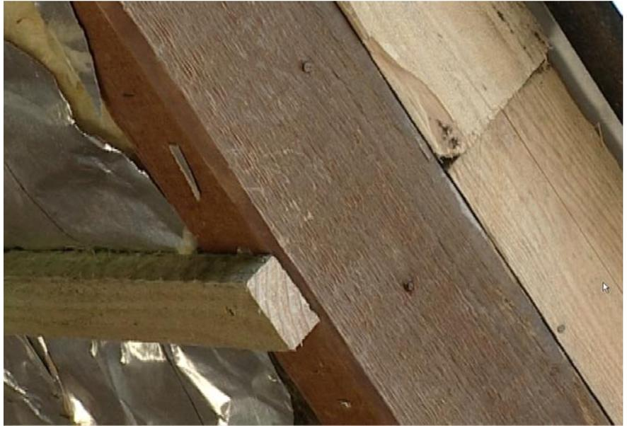
Der 12 cm starke Altsparren wurde hier 10 cm stark aufgedoppelt. Die Gesamtdämmstärke beträgt 22 cm. Zwischen die Lattung kam noch ein Untersparrenklemmfilz (2,4 cm) und raumseitig eine neue Luftdichtung bzw. diffusions-
