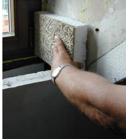
Innendämmung einer Gaubenwand mit einer Hartschaum-Holzwoleleichtbauplatten-Verbundplatte
