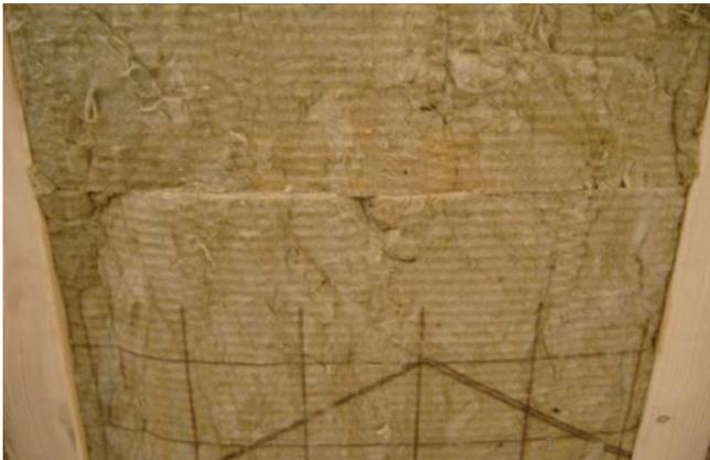
Dämmstoffe der Wärmeleitfähigkeitsstufe 035 bieten gute Dämmwirkung bei geringer Aufbauhöhe
