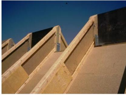
Der Dachstuhl eines Neubaus wurde mit Holz-T-Trägern aufgerichtet. Die Räume zwischen den Gurten sind teilweise schon mit Dämmstoff gefüllt. Damit beim Einlegen der Dämmplatten keine Hohlräume entstehen. Der schmale hohe Hartfaserplattensteg hat nur eine geringe Wärmebrückenwirkung.
