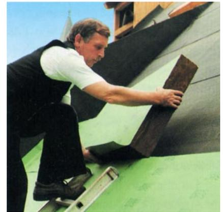
Dämmplatten aus Mineralfasern mit aufkaschierter Unterspannbahn
