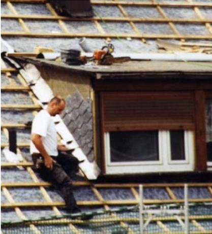
Hier wird bei der Dachneueindeckung die Dämmung der Gaubenwände und des Daches vergessen. Im Sommer wird dies weitere 50 Jahre für Überhitzung sorgen, die Wärmeverluste der dünnen Gaubenwände bleiben ebenfalls beträchtlich.
