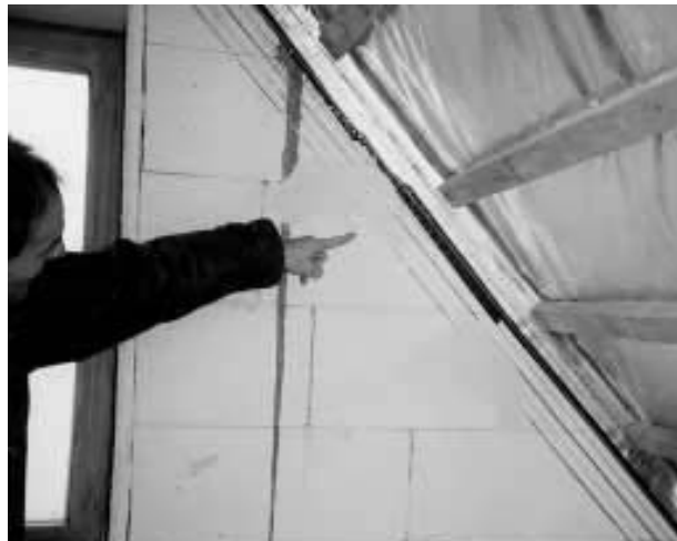
Hier wird die Dampfsperre mit Streckmetall an der Giebelwand gesichert und anschließend mit dem Innenputz eingeputzt.
