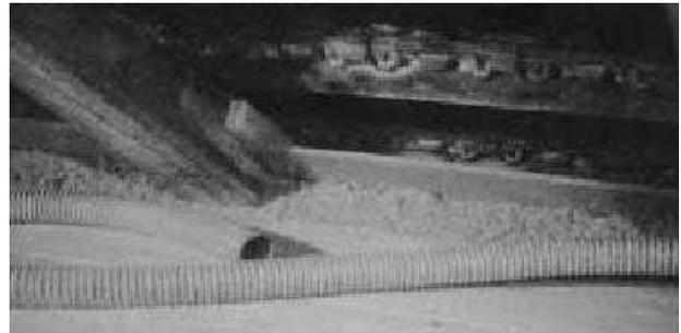
Hier wurden Zelluloseflocken vom Spitzboden in die Dachschräge geblasen.
