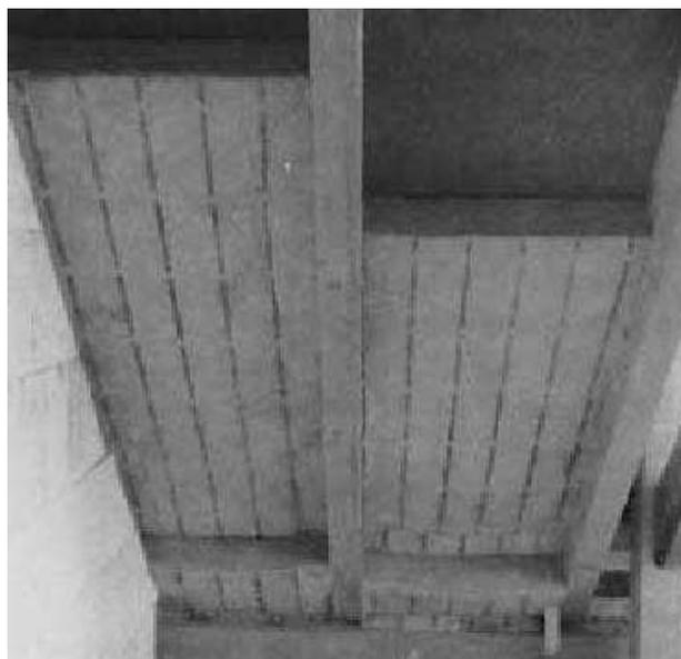
20 cm Sparrenhöhe sichern bei diesem Neubau eine Dämmstärke von 20 cm zwischen Sparren (unbelüftet). Unter dem Sparren werden zwischen einer Unterkonstruktion 25 mm starke Dämmplatten angeordnet. Eine Weichfaserplatte als Unterdach statt einer Unterspannbahn bietet einen zusätzlichen Wärmeschutz auf dem Sparren. Der U-Wert beträgt  $0,188 \text{ W}/(\text{m}^2 \text{ K})$ .
