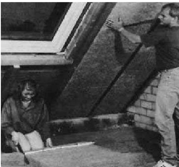
Bei unkaschierten Dämmstoffen, wie diesen Dämmkeilen können Ausführungsfehler korrigiert werden, weil man Fehlstellen beim Einbau sieht.
