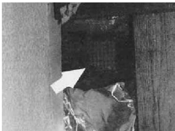
Durch dieses Loch in der Dämmung zwischen den Sparren blickt man bis auf die Unterspannbahn. Die warme Raumluft kann ungehindert entweichen. Die Folge sind nicht nur Wärmeverluste und unbehagliche Zugluft, sondern auch mögliche Bauschäden durch Tauwasserausfall an der Unterspannbahn.
