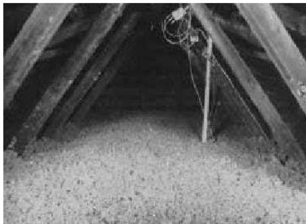
Von 500 auf rund 50 m<sup>3</sup> Erdgas pro Jahr konnten die Wärmeverluste durch diese Dachdecke (80 m<sup>2</sup>) reduziert werden. Die 20 cm starke Dämmung war mit dem Einblasverfahren in drei Stunden ausgeführt. Die Kosten: rund 1700 bis 1900 Euro.
