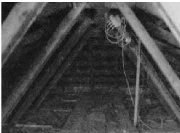
Bei diesem Dachboden trennt nur der Verputz und eine zusammengefallene Glaswolle (3 cm) die warme Raumluft von der Außenluft. Seit 1955 gehen so Jahr für Jahr 500 m<sup>3</sup> Erdgas verloren.
