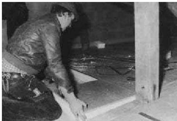
Hier wird die nackte Betondecke eines Reihenhauses mit 12 cm dicken Verbundplatten gedämmt. Die Kosten: rund 2100 bis 2300 Euro.
