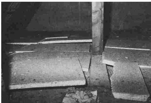
Hier ist die Dämmung nicht nur zu dünn, sondern auch völlig nutzlos, weil die Polystyrol-Platten nicht dicht anliegen.
