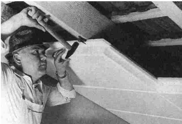
Bei diesem Dämmsystem aus Hartschaumplatten ist noch eine innere Folie gegen Lüftungswärmeverluste durch die Stoßfugen erforderlich.
