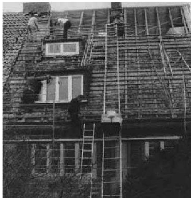
Bei diesem Gebäude wird die Dachneueindeckung mit einer Verbesserung der Dachdämmung verbunden. Eine Wohnungsbaugenossenschaft senkt durch Kombination von Instandsetzung und Dämmung Schritt für Schritt den Heizenergieverbrauch in ihrem Gebäudebestand.
