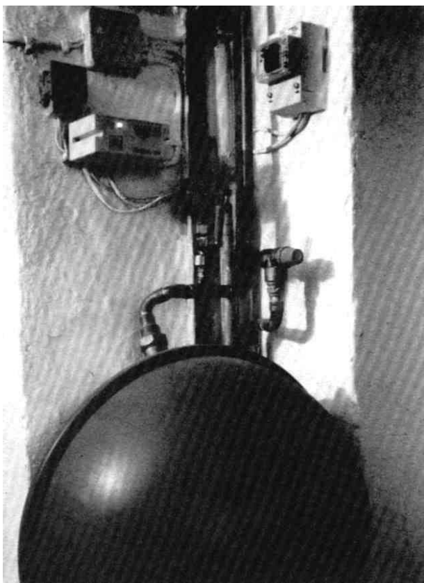
Regelgerät, Ausdehnungsgefäß und Sicherheitsventil
