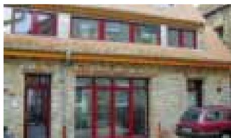
Das Bruchsteinmauerwerk wurde wieder verwendet. Passivhausfenster, umfangreiche Innendämmung, hohe Dichtheit und effiziente Lüftung ergeben einen exzellenten Wärmeschutz auf Passivhausniveau.
