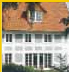
Die südliche Ziegelwand des Gebäudes wurde mit einem transparenten Wärmedämmverbundsystem versehen.
