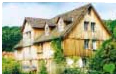
Die Lärchenholzverkleidung prägt das Aussehen der rückwärtigen Fassade. Dahinter verborgen: die umweltfreundliche Außen- dämmung mit Zellulose.
