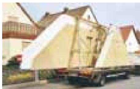
Vorgefertigte, mineralfaserge-dämmte Elemente erlauben die zügige, wärmetechnisch einwandfreie Erweiterung des Massivgebäudes
