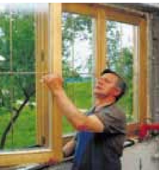
Durch Nachstellen der Beschläge bzw. Dichtungserneuerung können Zugerscheinungen und unnötig hohe Wärmeverluste bei intakten Fenstern vermieden werden.
