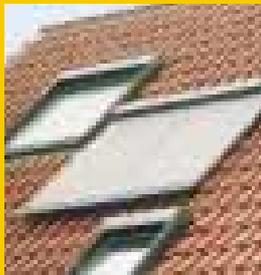
Das aufgestockte Dach schafft Raum auf zwei Wohnebenen. Ein kleines Modul hocheffizienter Vakuumröhrenkollektoren reicht zur wirksamen Unterstützung der Warmwasserbereitung.
