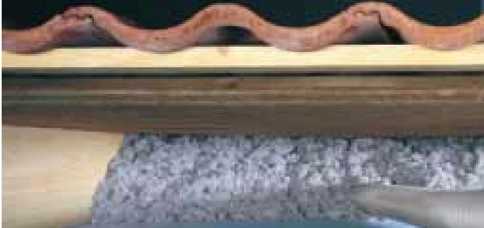
Bewohner ausgebauter Dachgeschosse werden von den nachträglichen Dämmarbeiten nicht belästigt. Denn isofloc gelangt von außen über einen Schlauch aufs Dach.
