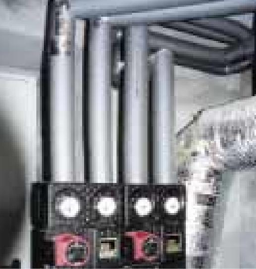
Frei verlegte Rohrleitungen müssen nachträglich gedämmt werden.
