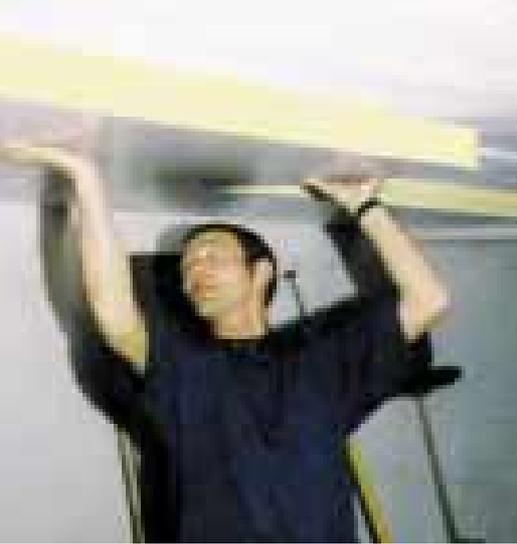
Zur Dämmung der Kellerdecke können Dämmplatten von unten an die Kellerdecke geklebt und gegebenenfalls verdübelt werden.
