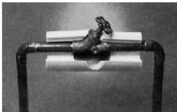
Dämmung einer Verteilleitung
