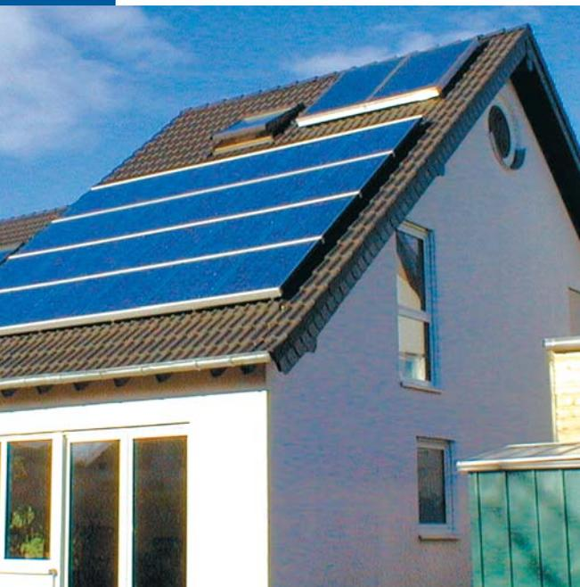
**Solarwärme und Solarstrom auf einem Dach genutzt.**
