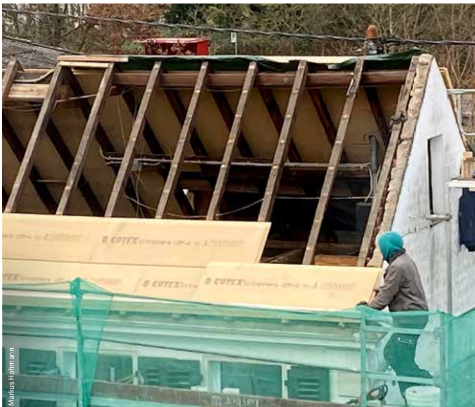
Die Wärmedämmung wird hier zwischen Dachsparren und Ziegeln aufgebracht.
