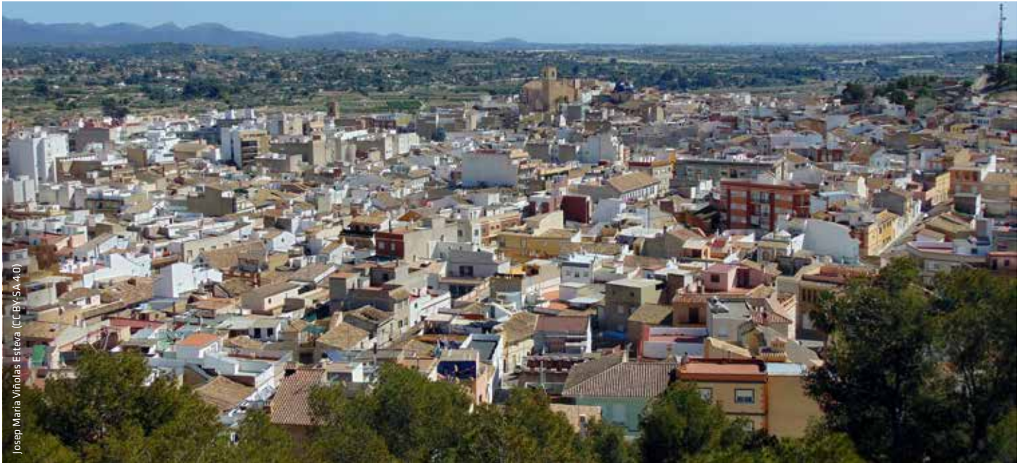
Hilft der Umwelt und dem Geldbeutel: Die Energiegemeinschaft Llíria, betrieben von Spaniens Energía und der Stadt Llíria, nutzt eine 39-kW-Photovoltaikanlage und reduziert damit die Stromkosten um 20 bis 30 %.
