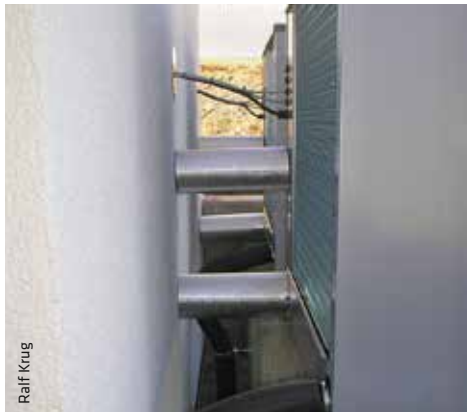
Vor- und Rücklauf der Heizung, Elektroleitungen und Kondensatablauf können bei Monoblöcken direkt angeschlossen werden.
