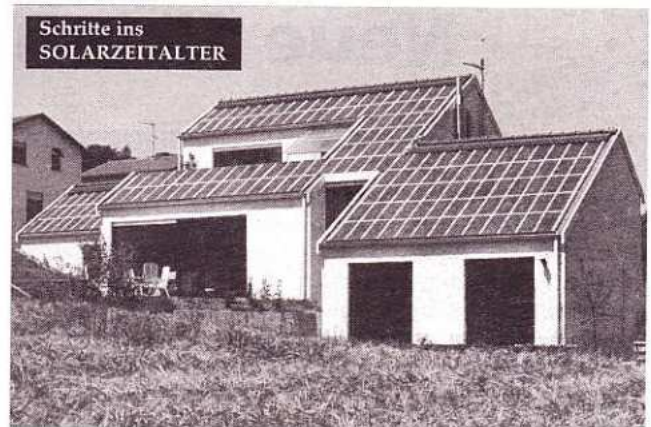
Das Pilotprojekt der Stadtwerke Saarbrücken liefert seit vier Jahren Strom aus Sonnenlicht – insgesamt fast 8000 kWh im Jahr.
