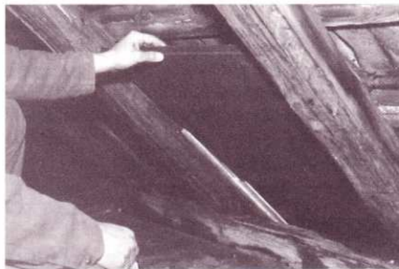
Die Holzfaserplatten werden eingeführt
