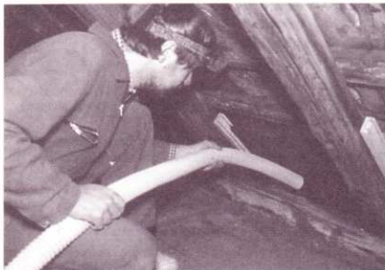
Isfloc wird eingeblasen.
