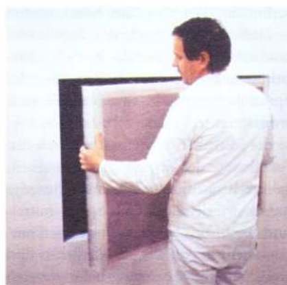
So werden TWD-Elemente in die Lücken des Wärmedämm-Verbundsystems eingesetzt.
