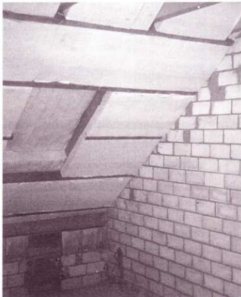
NEH-gerechte Dachkonstruktion mit 18 cm Dämmung zwischen den Sparren und zusätzlich 10 cm Dämmung zwischen einer inneren Querlattung ( k -Wert = 0,15 \text{ W/m}^2 \cdot \text{K} ).
