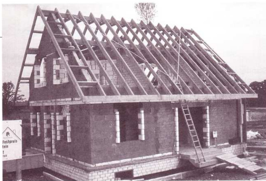
NEH aus Ziegelmauerwerk im Rohbau mit Porenbeton als unterster Steinreihe im EG und an den Fenster- und Türanschlüssen zur Vermeidung von Wärmebrücken.
