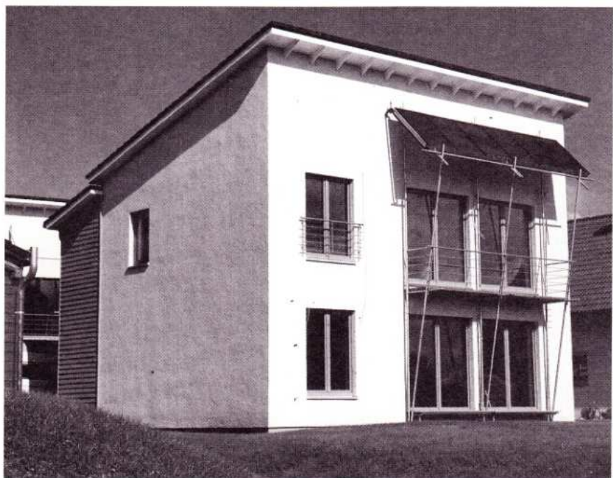
Passiv-Einfamilienhäuser in Lindlar in Holzbauweise verputzt
