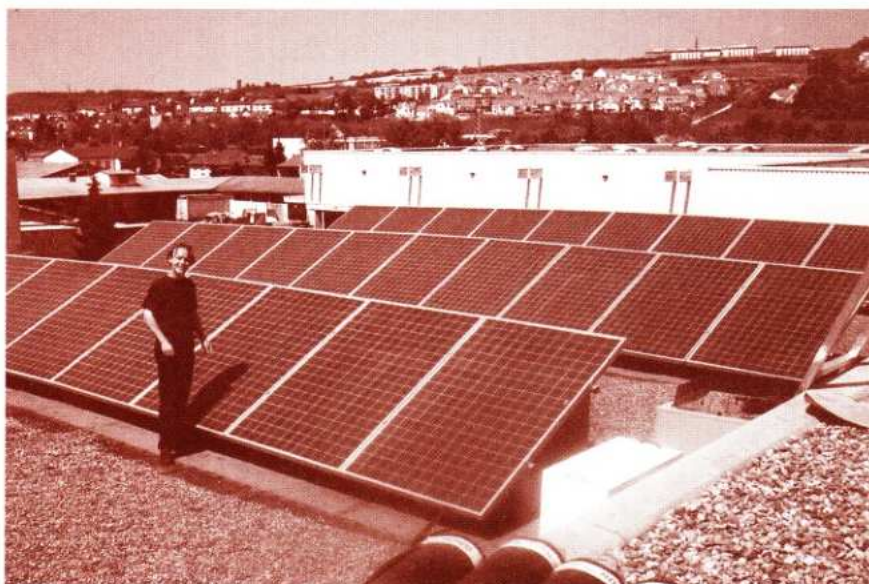
Photovoltaik-Beteiligungsanlage auf dem Firmendach der Fa. Gröner in Ulm mit 24 kWp
