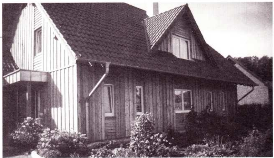
Passivhaus in Bocholt in Holzbauweise mit Holzbekleidung
