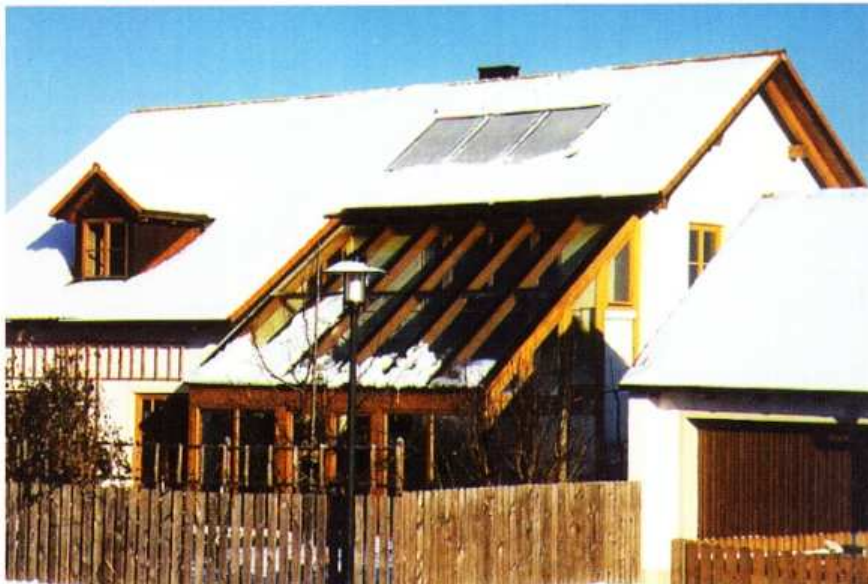
Nur schlecht gedämmte Dächer lassen Schnee schmelzen
