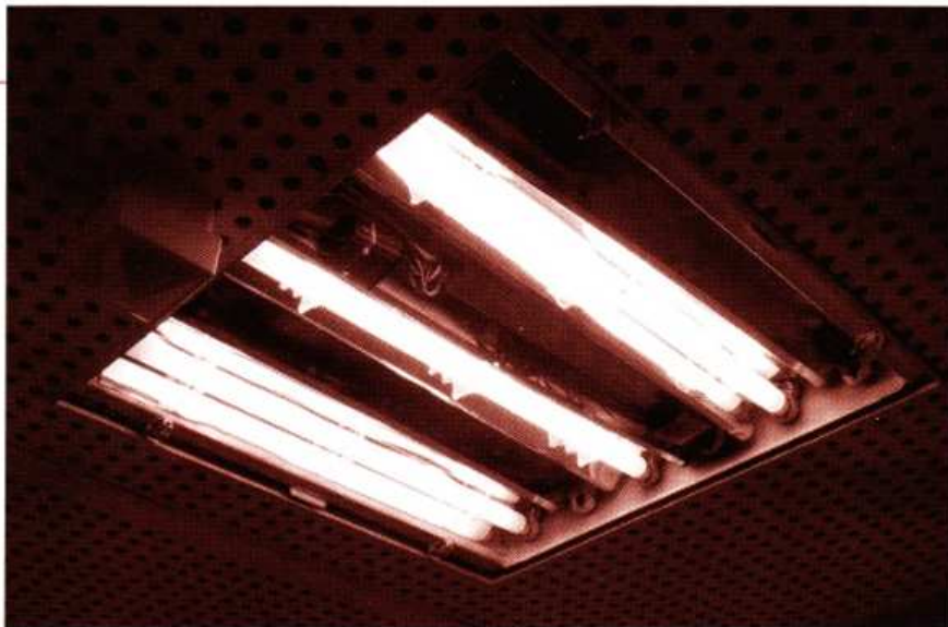
Leuchtentuning von 150 Watt auf 56 Watt bei gleichzeitig hellerer und besserer Beleuchtung. Vorher 6 Lampen ohne Reflektor, jetzt (Foto) 3 Lampen und Reflektor.
