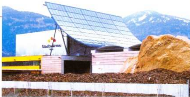
Das Prunkstück der Stadt Lienz, das moderne Biomasse-Heizkraftwerk, wurde mit dem Energy-Globe ausgezeichnet. Es versorgt 3.500 Einzelanschlüsse der Stadt und hat auf dem Dach eine Kollektoranlage von 630 qm.
