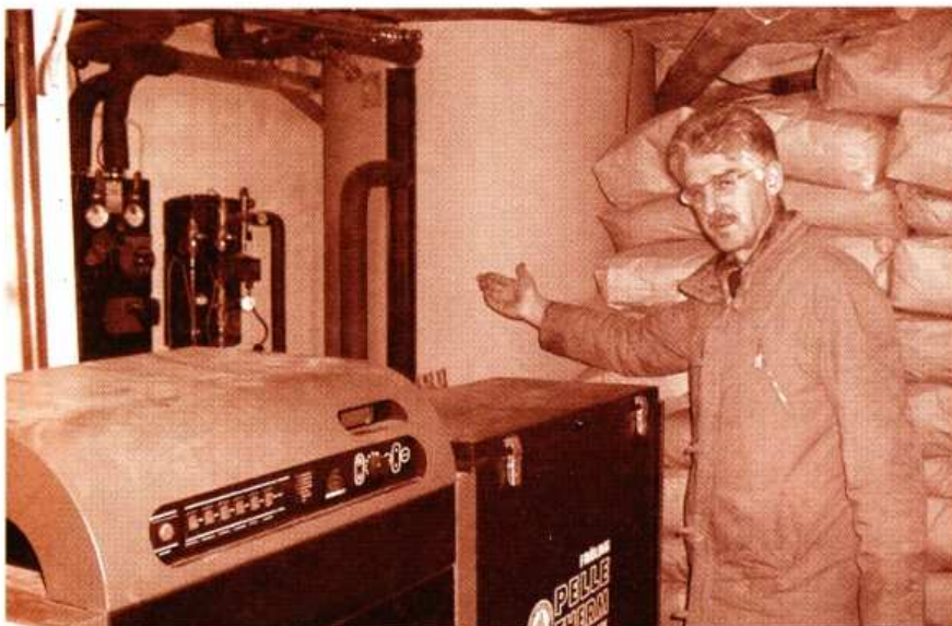
Dr. Justinger und sein Pelletkessel, im Hintergrund der Speicher der Phönix-Solaranlage. Hier wurde erfolgreich eine Phönix C-Anlage mit einer Fröling Holzpelletzentralheizung kombiniert. In den Säcken lagern die Pellets.
