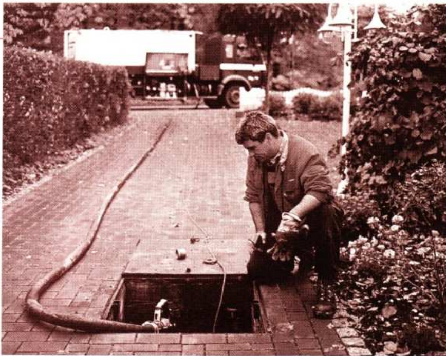
Ein unterirdischer Erdgastank wird befüllt.
