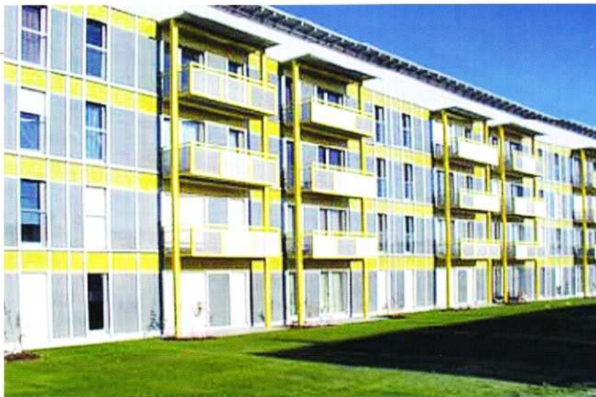
Solarcity: Passivhaus in Linz (Österreich), 1.400 qm Solarfassade, Energiekennzahl: 7,3 kWh/qm a.
