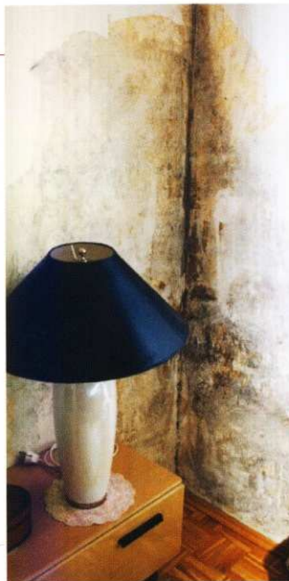
Schlecht gedämmte Wände als Schimmelbefall
