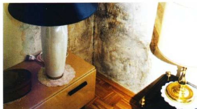
Seite 36: Schlecht gedämmte Wände verursachen Schimmelbefall
