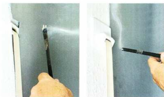
Seite 32: Gurtöffnung vor der Sanierung und danach
