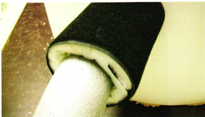
Manschetten: Anschlüsse lassen sich durch Flexmanschetten einfach dämmen.
