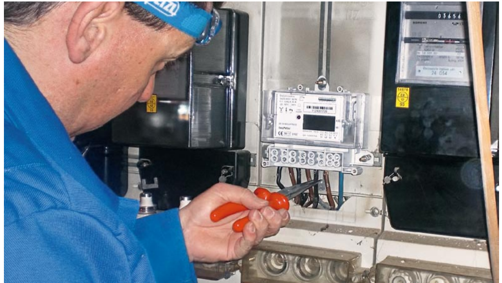
Der Discoveryg-Zähler wird installiert.
