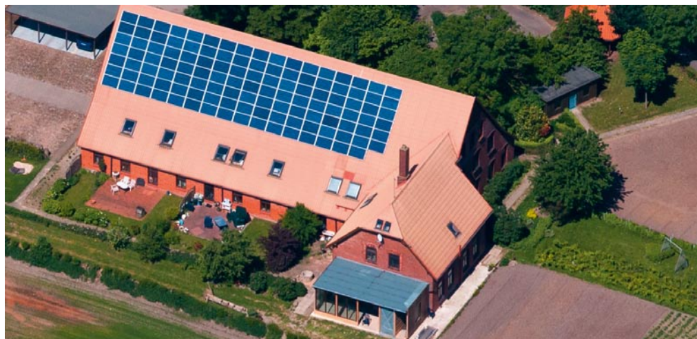
In diesem Mehrfamilienhaus nördlich von Hamburg versorgt eine 30-kWp-PV-Anlage sowie ein hocheffizientes BHKW mit 7,5 kW elektrischer Leistung acht Wohnungen und eine Werkstatt über eine Kaskadenmessung (siehe Infobox auf Seite 35) im Rahmen einer Lohnverstromung durch den Hauseigentümer. Der Strombezug aus dem Netz konnte mit beiden Anlagen zusammen um 90 Prozent reduziert werden.
