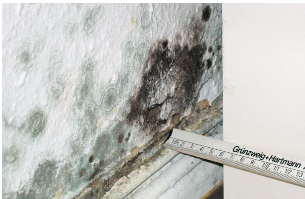
Wenn die Möbel zu dicht an der Wand stehen, kühlt eine dahinter befindliche Außenwand ab. Kondenswasser und Schimmel können die Folge sein
