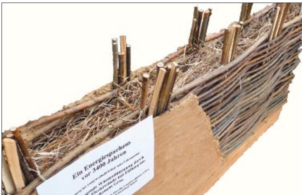
Rekonstruktion der Energiesparwand aus der Bronzezeit: K-Wert zwischen 0,5 und 1,0 W/(m 2 K) erreichen Neubauten erst seit 1995
