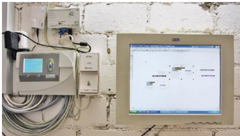
Über die eigene Programmierung und den Einbau der universellen Regelung UVR1611 berichtet auch Frank Töllen aus Magstadt sehr ausführlich auf seiner Webseite www.toellen.de
