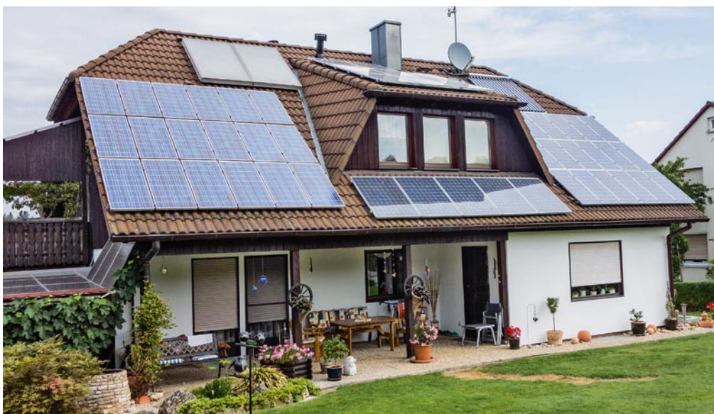
Energiewunderhaus von Tomas Reger: Vier PV-Anlagen, ein Heizkessel, zwei Solarthermieanlagen, ein Blockheizkraftwerk und eine Wärmepumpe arbeiten dank einer übergeordneten Steuerung optimal zusammen. Livedaten und historische Entwicklungen sind unter www.online-bhkw.de abrufbar.
