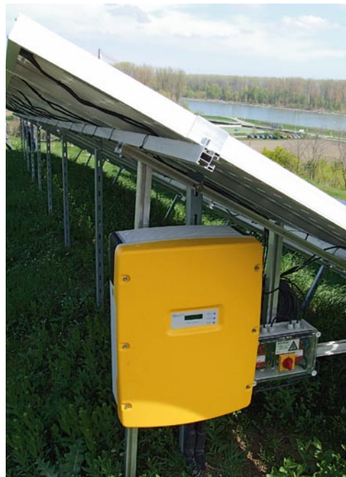
Solaranlage mit Wechselrichter in Speyer
