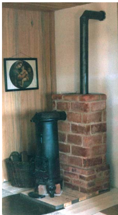
Historischer Kohleofen. Vorher: Dreckschleuder. Mit Heizzug: saubere Holzfeuerung mit Dauerwärme.
