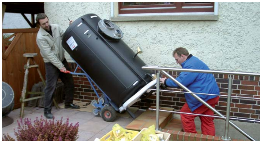
Der Speicher muss durch die Kellertür passen. Große Speicher können aber auch erst im Keller zusammengesweißt werden.
