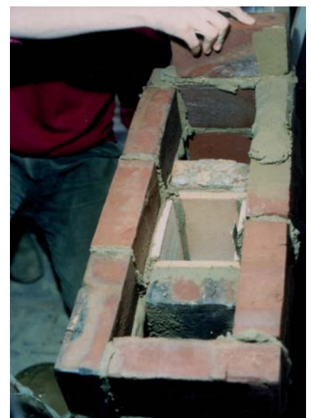
Aus Vollziegeln ist der Bau besonders einfach und erreicht den Heizeffekt des Kachelofens für einen Bruchteil des Preises.
