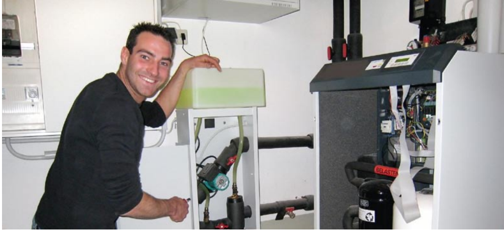
Da kommt Freude auf: Eine Erdsonden-Wärmepumpe mit einer Jahresarbeitszahl von mehr als 4.
