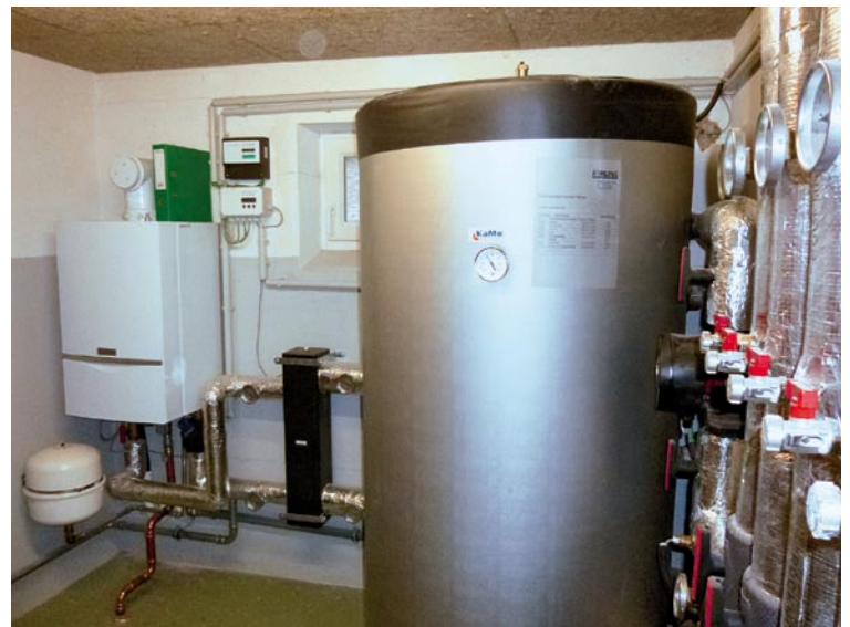
Blick auf die Heizzentrale mit 750-Liter-Speicher
