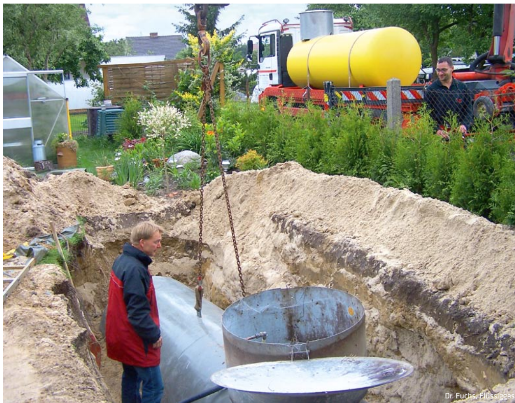
Ein Flüssiggastank wird im Garten eingebracht
