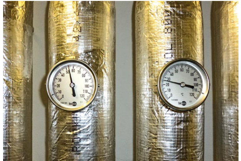
Vorlauftemperatur 55 Grad, Rücklauftemperatur 25 Grad, dadurch volle Brennwertnutzung.
