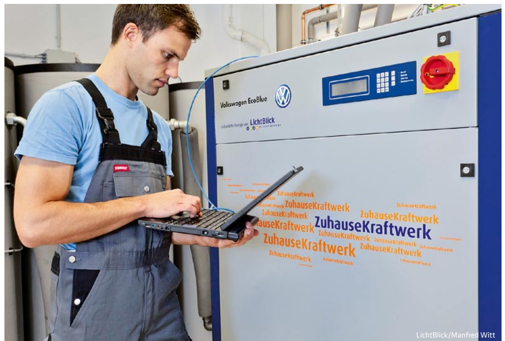
Hocheffiziente Kraft-Wärme-Kopplung vom Fließband: ZuhauseKraftwerke erzeugen aus Erdgas mit einem Verbrennungsmotor von Volkswagen klimafreundlich Wärme und Strom.
