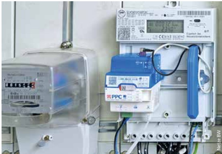
Alt gegen Neu: Analoge Ferrariszähler (links) haben endgültig ausgedient! Moderne Messeinrichtungen (rechts) sind elektronische Stromzähler, die optional mit einem Smart-Meter-Gateway (blau) ausgerüstet werden können.
