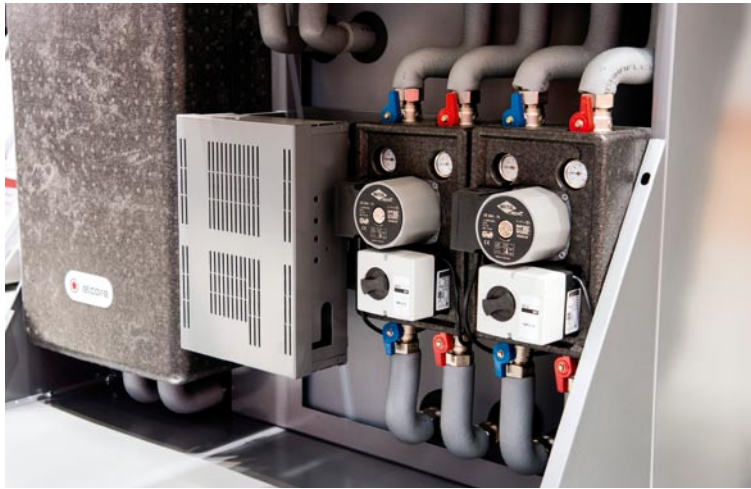
Pumpengruppen, Speichertanks, Warmwasserbereitung und gegebenenfalls eine Systemtrennung gehören zur Standardausrüstung einer Brennstoffzellen-Energiezentrale für den Heizungskeller.
