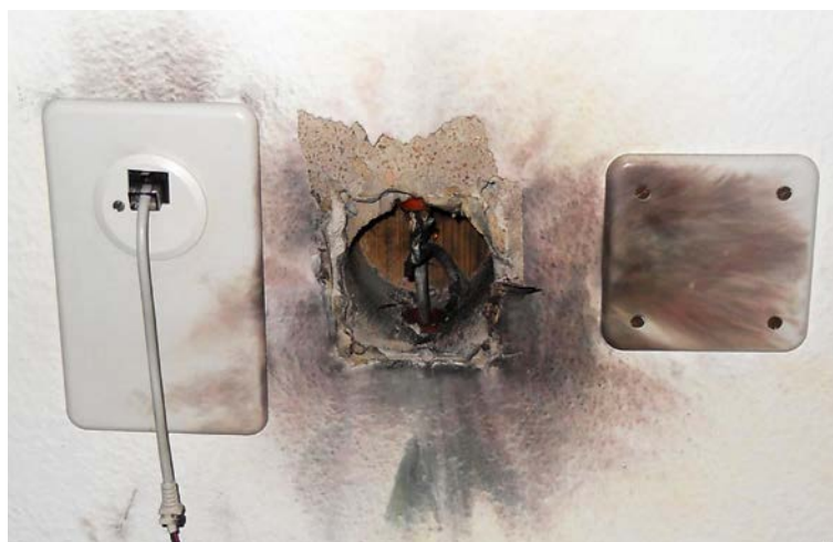
Nicht nur aus dem Stromnetz, auch über das Telefonnetz, Antennen- oder Kabelfernsehen kann Überspannung zu Schäden führen. In diesem Beispiel kam die Entladung aus der Fernsehdose und ist auf Heimnetzwerk und Elektroverteilung übersprungen.
