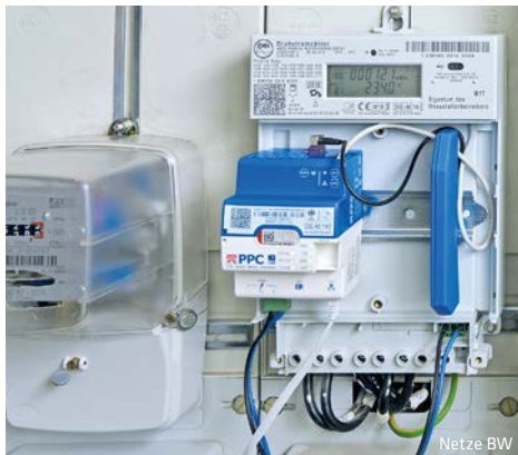
Einbau des ersten zertifizierten Smart-Meter-Gateways (blau) vom Hersteller PPC mit LTE-Mobilfunkantenne in eine moderne Messeinrichtung
