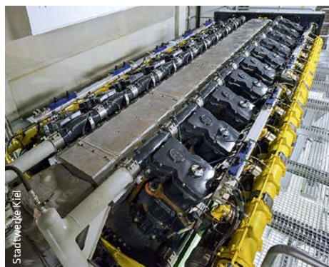
Herzstück des Küstenkraftwerks sind 20 Blockheizkraftwerke vom Typ Jenbacher J920 FlexExtra. Das gesamte Kraftwerk wird für die Stadtwerke vom Generalunternehmer Kraftanlagen München errichtet.
