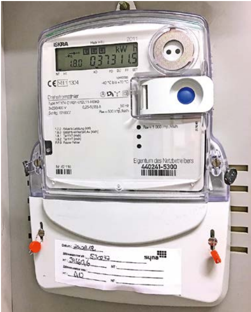
Der Stromzähler am Vereinssitz vom Bund der Energieverbraucher e.V. war bis vor wenigen Wochen ein MT174-Zähler mit Rogowskispulen. Der Verein hat daher den Messstellenbetreiber gewechselt und von Discovery einen smarten Zähler mit Shunt-Messung einbauen lassen.
