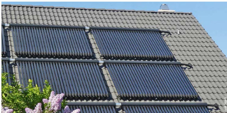
Nicht nur als Freiflächenanlage, auch auf Wohnhäusern können Solarthermieanlagen in Kombination mit Nah- oder Fernwärme eine effiziente und umweltfreundliche Lösung sein.
