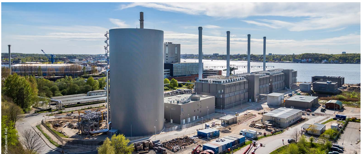
Vom außerhalb des Stadt-Kerngebietes liegenden „Küstenkraftwerk“ mit seinem 30 Millionen Liter Wärmespeicher verläuft unter der Kieler Förde hindurch ein Tunnel mit den Fernwärmeleitungen zu den 70.000 Wärmeabnehmern der Stadtwerke.
