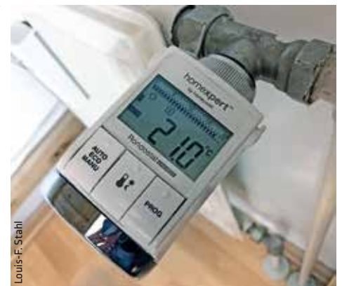
Präzisere Regelung: Elektronische Thermostate wie dieses Honeywell HR25 erlauben die Einstellung der Temperatur auf 0,5 °C genau und die Programmierung von Heizplänen mit Hoch- und Absenkenphasen.
