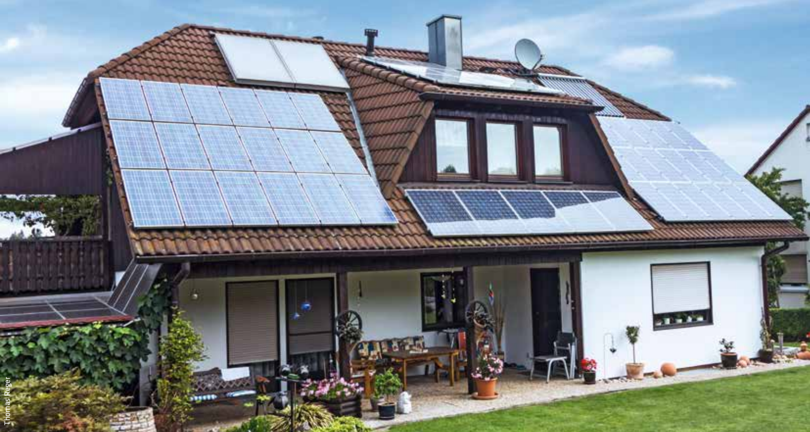
Vorreiter der Energiewende: Zusätzlich zum Wärmeertrag aus einer Solarthermieanlage erntete Vereinsmitglied Thomas Reger mit drei Photovoltaikanlagen (4,3 kWp Baujahr 2000, 2,1 kWp Baujahr 2004 und 1,2 kWp Baujahr 2010) im Jahr 2019 insgesamt 5.968 kWh Sonnenstrom. Das im Heizungskeller stehende BHKW vom Typ „Dachs“ mit 5,3 kW erzeugte letztes Jahr zusätzlich weitere 5.987 kWh Strom. Die Daten aller Anlagen sind in Echtzeit im Internet abrufbar: www.online-bhkw.de
