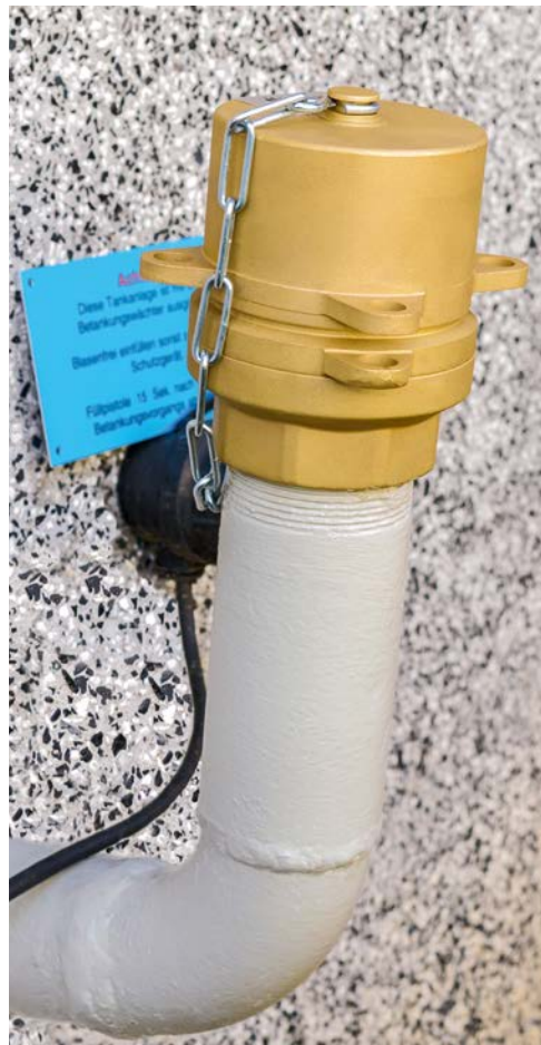
Der Betankungswächter ersetzt den Deckel auf dem Einfüllrohr. Damit ist der Einbau schon erledigt. Das Gerät braucht keinen Stromanschluss. Auf dem Foto ist auch der vorgeschriebene Grenzwertgeber zu erkennen, der mit dem Betankungswächter nichts zu tun hat.
