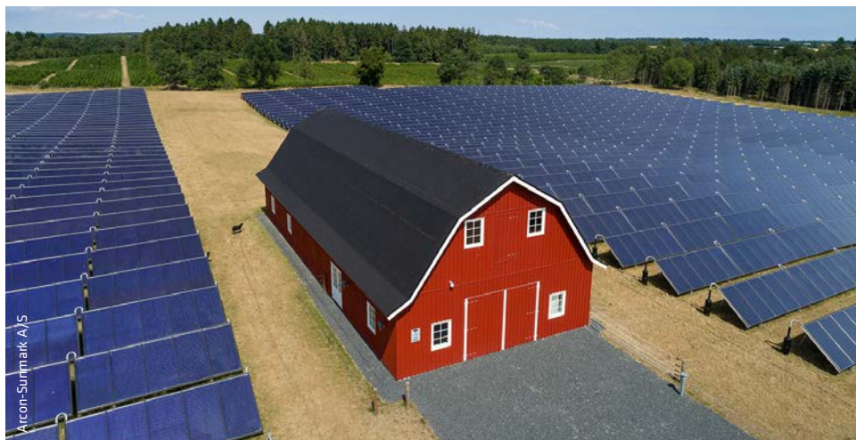
Der im Jahr 2015 in Betrieb genommene Solarpark Hadsund in Dänemark verfügt über eine Kollektorfläche von 20.513 Quadratmetern und erzeugt eine Spitzenleistung von 14 Megawatt.
