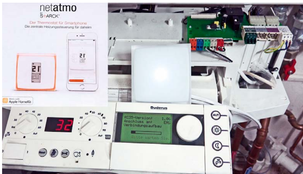
Einbau vom Netatmo Thermostat in eine Buderus-Brennwerttherme. Nur zwei Adern müssen im Kessel angeschlossen werden (oben rechts). Das Relais (Mitte) schaltet darüber die Wärmeanforderung. Vorlauftemperatur und Heizkurve werden weiterhin vom Kessel gesteuert (unten). Der Funk-Raumthermostat (Verpackung oben links) wird im Wohnraum positioniert.
