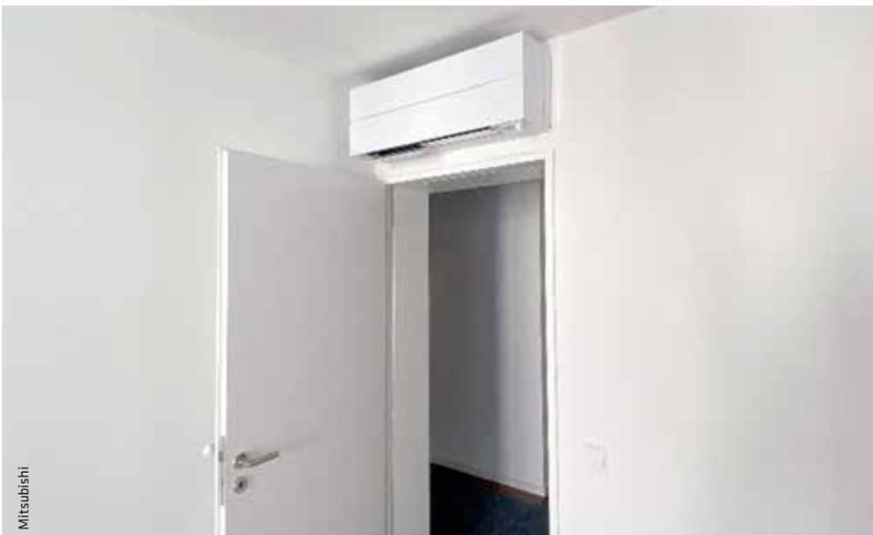
Die Wärmepumpe heizt die Luft im Raum und ist zugleich eine Klimaanlage, die im Sommer kühlt – auch sehr nützlich bei künftigen Hitzewellen.
