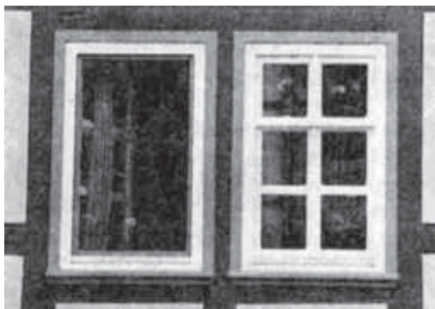
Modernes Holzrahmenfenster mit Isolierverglasung
