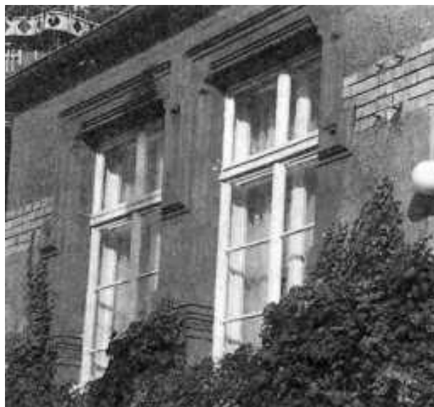
Verbundfenster im Denkmalschutz: Außen Einfachverglasung mit Sprossen, innen durchgehende Isolierglasscheibe.
