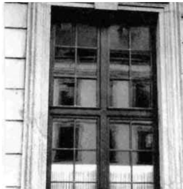
Stadtschloß Fulda: Holz-Einfachrahmen mit historischer Sprossenteilung als Aufsatz in Blei nehmen hier eine Isolierverglasung auf. Bei Verglasungersatz kann sie problemlos durch Wärmeschutz-Isolierverglasung ersetzt werden.
