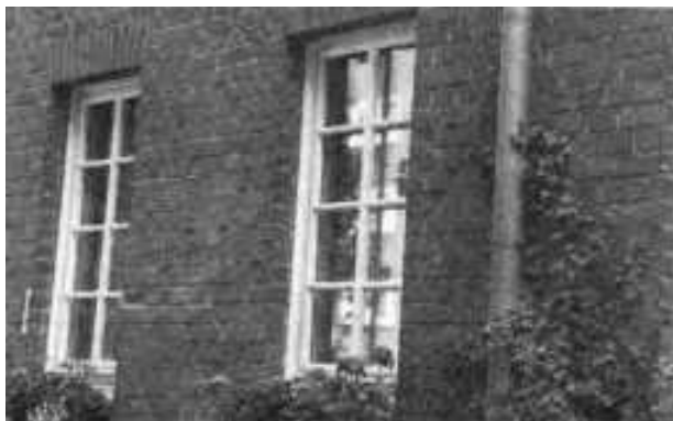
Verbundfenster im Denkmalschutz: Außen Einfachverglasung mit Sprossen, innen durchgehende Isolierglasscheibe.
