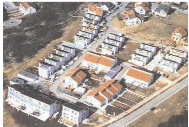
Niedrigenergie-Siedlung „Distelweg“, Niedernhausen
