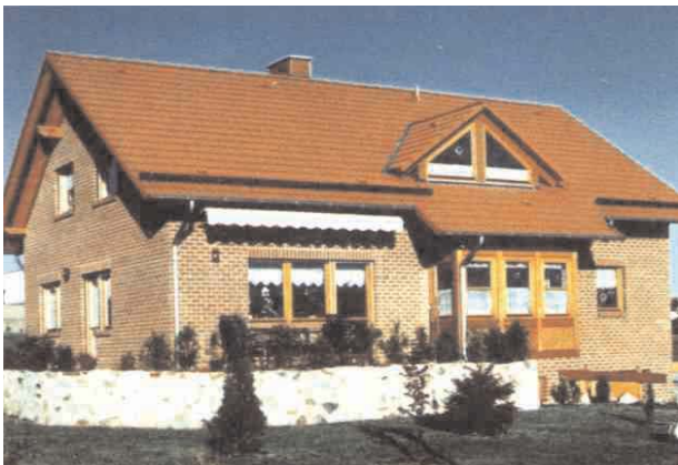
Einfamilienhaus in Frankenberg / Eder
