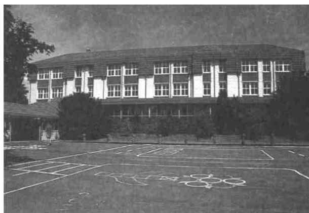
Modellhafte Wärmetechnische Sanierung einer Grundschule (Baujahr 1970) in Freiensteinau auf das Einsparniveau des Niedrigenergie-Standards
