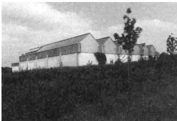
Turnhalle in Biblis im Niedrigenergie-Standard
