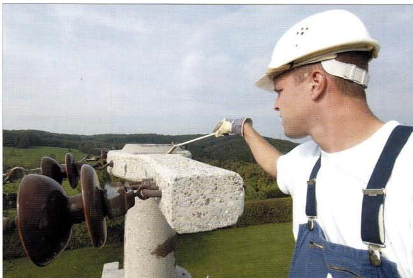
Verfüllen von kleinen Rissen an der Traverse mit Epoxydharz durch Pinselinjektion
