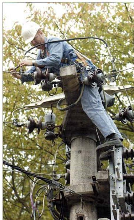
Montage einer Stromschleife an einer Betonmaststation
