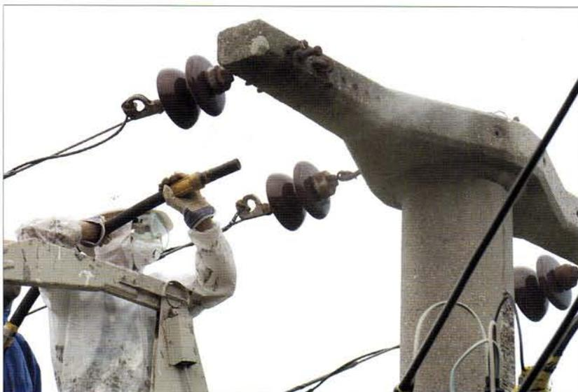
Monteur beim Druckluftstrahlen mit Strahlgut eines Betonmastes im Mastzopf- und Traversenbereich
